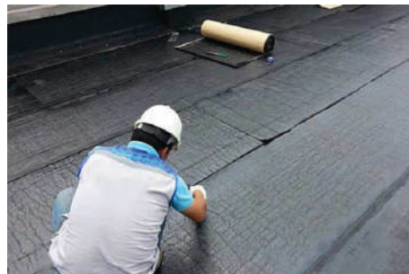
Thi công chống thấm mối nối các tấm hoặc toàn bộ bề mặt sàn tại những vị trí yêu cầu (sàn ngoài trời, sàn toilet,...).
