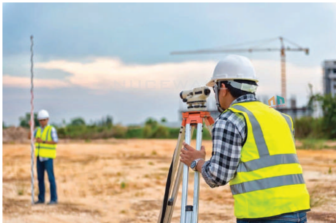
Dùng thiết bị để định vị vị trí thi công tường rào.
