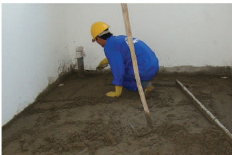
Cán vữa nền hoặc thi công lớp vữa topping hoàn thiện.
